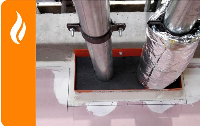
為滿足60分鐘隔熱要求，僅須於所要求的（或所有的）部件用TWrap包圍。須要確保TWrap的每一側都各自重疊75mm，並能觸及FyreBOX™的塞縫海綿。於三個位置牢牢套上TWrap，用強力鋁卷帶或不銹鋼索帶包圍整個外部。
