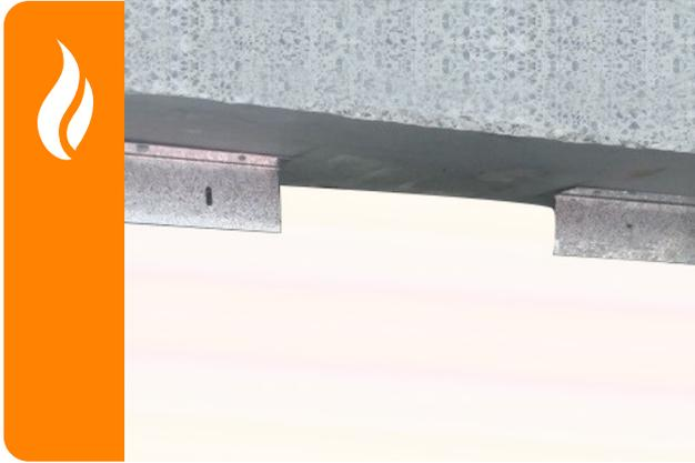
於FyreBOX™任何一側，裝上Hebel的牆壁固定邊角
