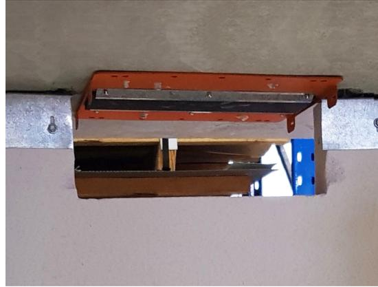
依照供應商指示，安裝Hebel外牆嵌板。確保FyreBOX™與外牆開口的環狀間距於5mm至20mm之間。
