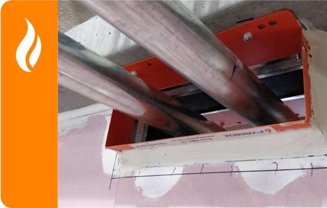
在FyreBOX™與外牆開口的環狀間隙，使用FyreFLEX密封劑填至20mm深。最後，在FyreBOX™每側的邊緣位置填上長30mm及闊30mm的密封劑。
