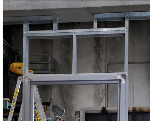
安裝外牆支架，將FyreBOX™四周圍起。並依照牆壁建造指示，固定石膏板。確保FyreBOX™與外牆開口的環狀間距於5mm至20mm之間，並依照要求，提供測量偏移空間。
