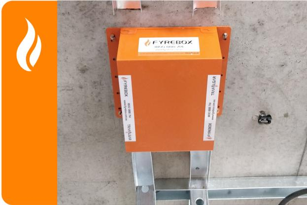
取回FyreBOX™底部，環繞組件，並將其圍在牢牢緊扣的頂部，確保所有鑲嵌固件正確鎖定於適當位置。
