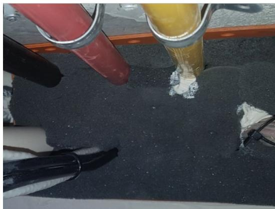
用剩餘的塞縫海綿或FyreFLEX密封劑填塞末端任何顯眼的縫隙。請注意：安裝完海綿後，建議給此項工序拍照，作為現場紀錄之用，以證明安裝流程符合規則。
