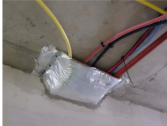
為滿足90分鐘隔熱評級的要求，僅須使用TWrap包圍部件及FyreBOX™外殼，令嵌板下側的邊緣展開，對準嵌板底部。嵌板下側的邊緣應該互相重疊至少50mm，並使用30x1x300mm大小的鋼片整齊排放。於距離嵌板其中一側50mm的位置及一個置中位置，須要使用高強度鉚釘將鋼片固定。確保TWrap其中一側觸及外牆和包圍FyreBOX™，並於介面的邊緣位置，填上長20mm及闊20mm的Fyreflex密封劑。
